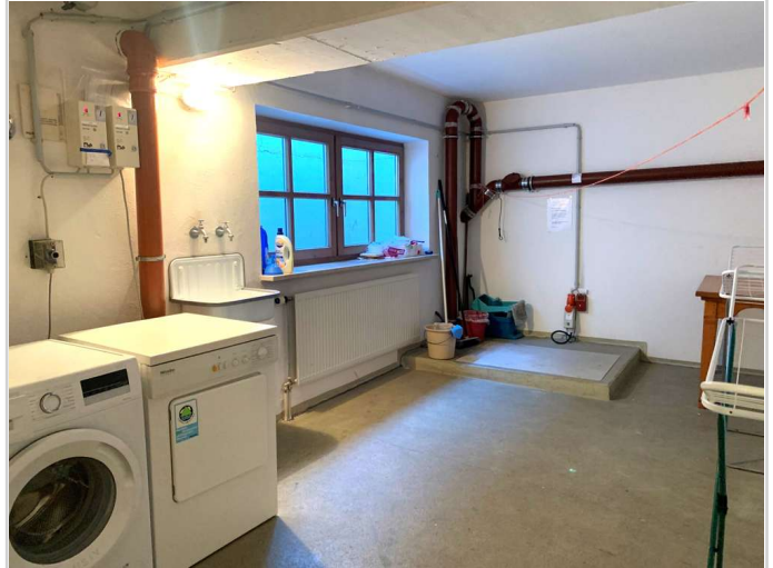
Wasch und Trockenraum
